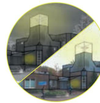
Aufsatz eines gläsernen, nachts beleuchteten Körpers zur Erhöhung der Sichtbarkeit
